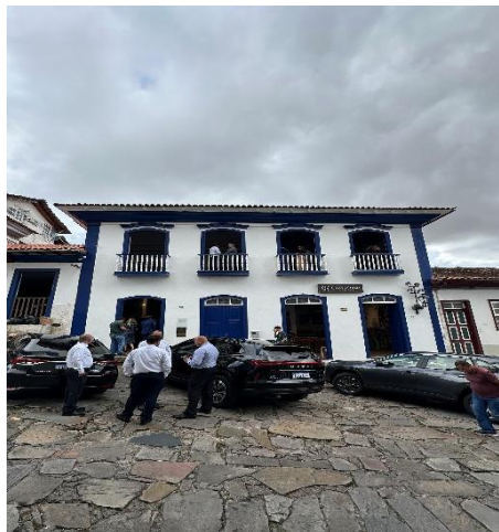
Fachada frontal da Casa do Intendente Autoria: Francisco Luz Data: 20/02/2026
